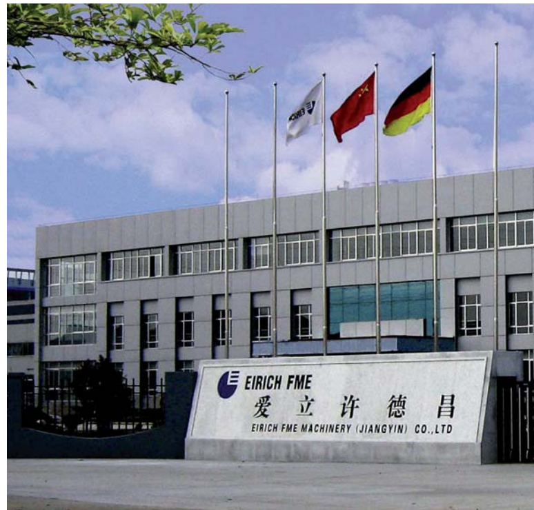
Firmengebäude der Firma Eirich in China.
